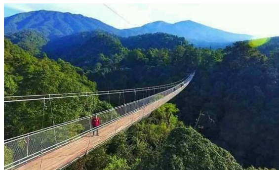
Jembatan Gantung Situgunung dilihat dari arah lain
